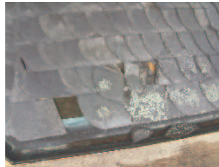
Gefährlicher Zustand des Schiefers
